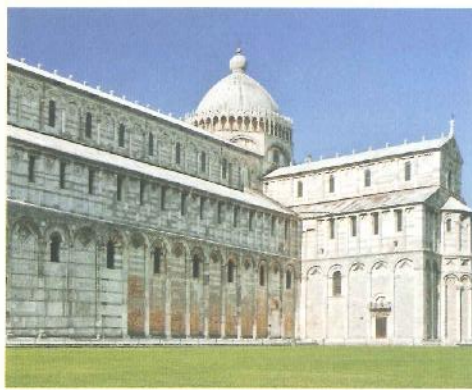
Estrutura com abóbadas suportadas por pilares e paredes espessas – torres e arcos.
