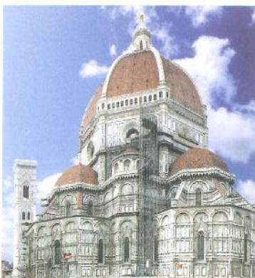
Estrutura com cúpula.
