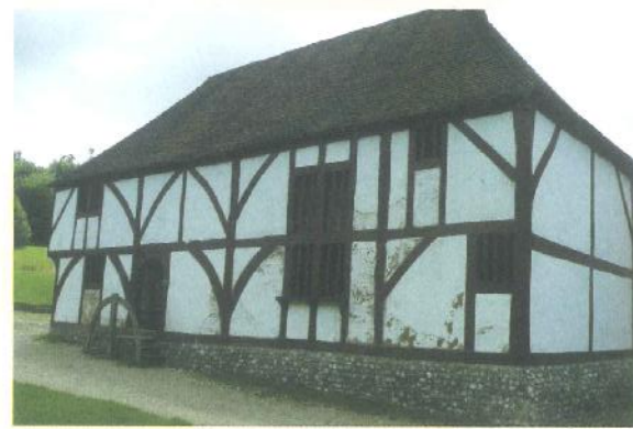
Estrutura de madeira – vigas, pilares, paredes de taipa e telhados inclinados.
